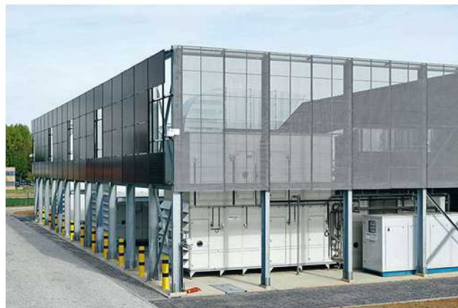
Le 2 e datacenter de Sopra Steria est hébergé chez Engie Cofely à Gembloux.
